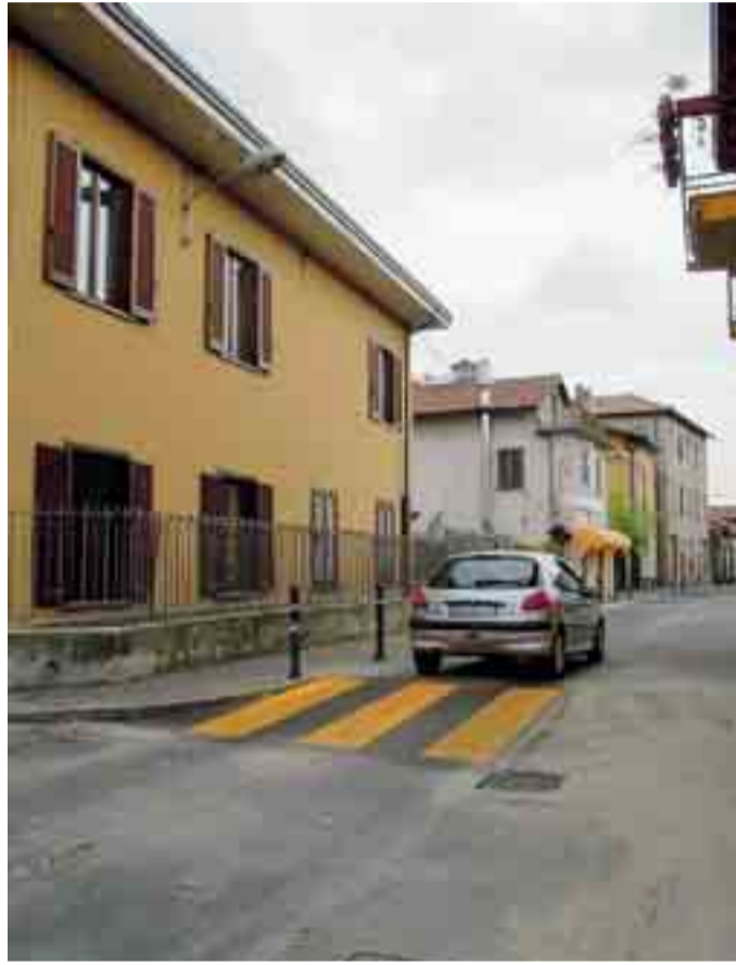
Il dosso di via Padulli a Cabiate è stato abbassato
